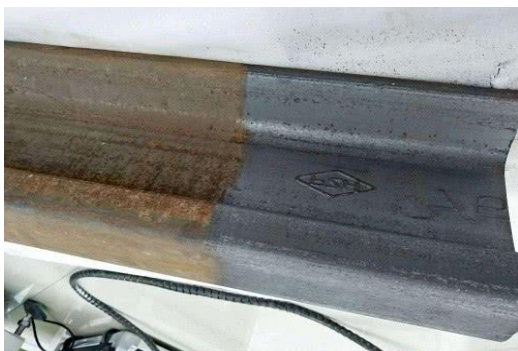
高铁轨道除锈
