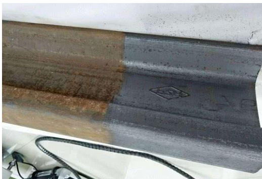
高铁轨道除锈
